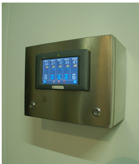
Interface console 7" et supervision sur PC tactile 19" Château Mauvesin-Barton (Moulis-en-Médoc) / Installation 2013
