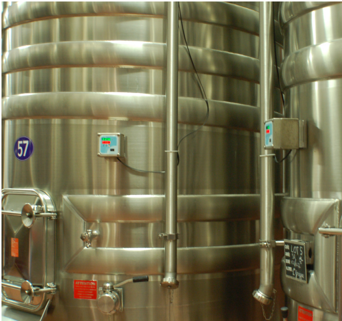
Supervision PC client et afficheur sur chaque cuve Château Montrose (Saint-Estèphe) / Installation 2013-2014
